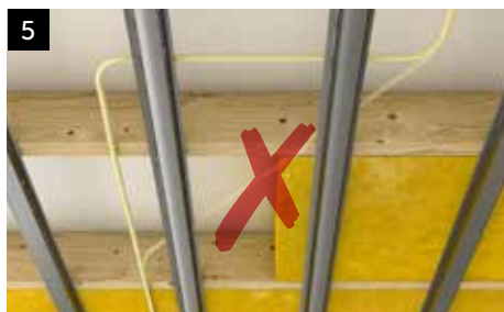
5 El- och VVS-rör skall monteras parallellt eller vinkelrätt mot profilen och får ej klämmas mellan bjälke och profil.
