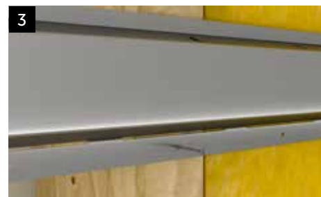
3 Profilens fästs med skruv i det förborrade hålet eller högst 25 mm därifrån. Detta så att profilen inte förlorar den fjädrande effekten.
