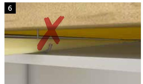
6 Kontakt mellan upphängning för t.ex. VP-rör och gipsskiva ger kraftigt försämrad ljudisolering.
