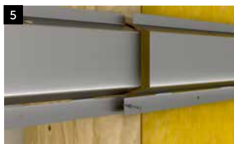
5 Skarvning sker alltid över regel med profilerna kant i kant och de båda förborrade hålen rakt över varandra. Skarvarna bör förskjutas i förhållande till varandra.
