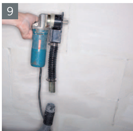
Vid fräsning för elrör kopplas dammsugaren till dammsugskåpan.
