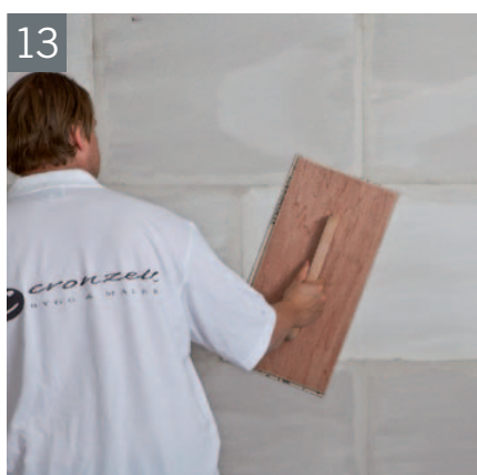
Innan spacklings-, tätskikts- eller annan behandling bör man slipa av ytan med en slipbräda för att ta bort ojämnheter.
