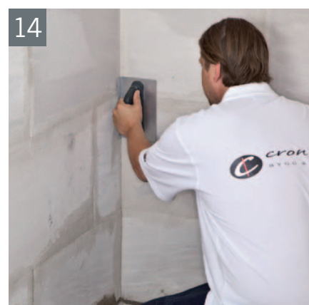
Slipa även innerhörn samt tak- och golvinkel för att ta bort ojämnheter.
