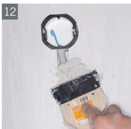
Laga spåret med H+H lagningsbruk.
